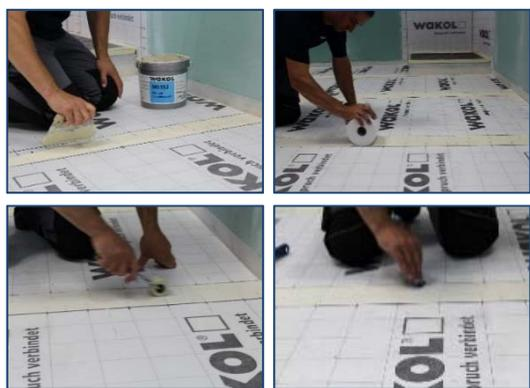
**\*7ème étape //** Appliquer la WAKOL MS 552 Colle pour PVC et caoutchouc dans la zone marquée, à gauche et à droite du joint de la membrane et laisser gommer la colle au moins 20 minutes.
