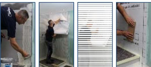
**\*5ème étape //** Appliquer la WAKOL MS 552 Colle pour PVC et caoutchouc avec denture TKB B1 au mur et laisser gommer la colle env. 20 minutes pour augmenter la prise initiale.
