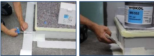
**\*3ème étape //** Découper la WAKOL AS 152 Bande d'étanchéité à la longueur nécessaire; faire chevaucher l'angle d'étanchéité d'env. 5 cm.
