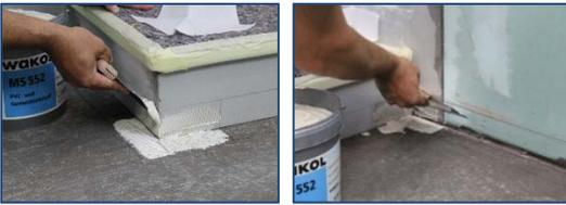
**\*2ème étape //** Appliquer la WAKOL MS 552 Colle pour PVC et caoutchouc avec denture TKB B1 dans la zone des angles intérieurs et extérieurs.
