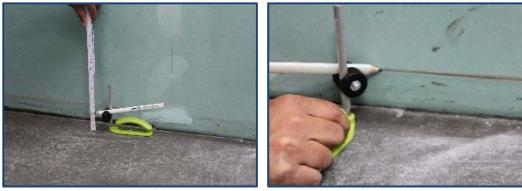
**\*1ère étape //** Marquage des zones de remontée murale pour l'application de colle au mur et au sol sur une hauteur et une largeur de 6 cm.
