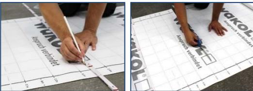
**\*4ème étape //** Marquer et découper la WAKOL AS 151 Membrane d'étanchéité pour le sol et le mur.
